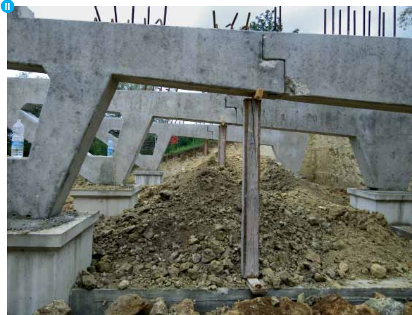
II-V La struttura del corpo fisso è di cemento armato prefabbricato. La difficoltà di accesso ha obbligato a sezionare in due le travi di sostegno • The fixed volume's structure is in prefabricated reinforced concrete. Lack of accessibility required the load-bearing beams to be split into two sections
