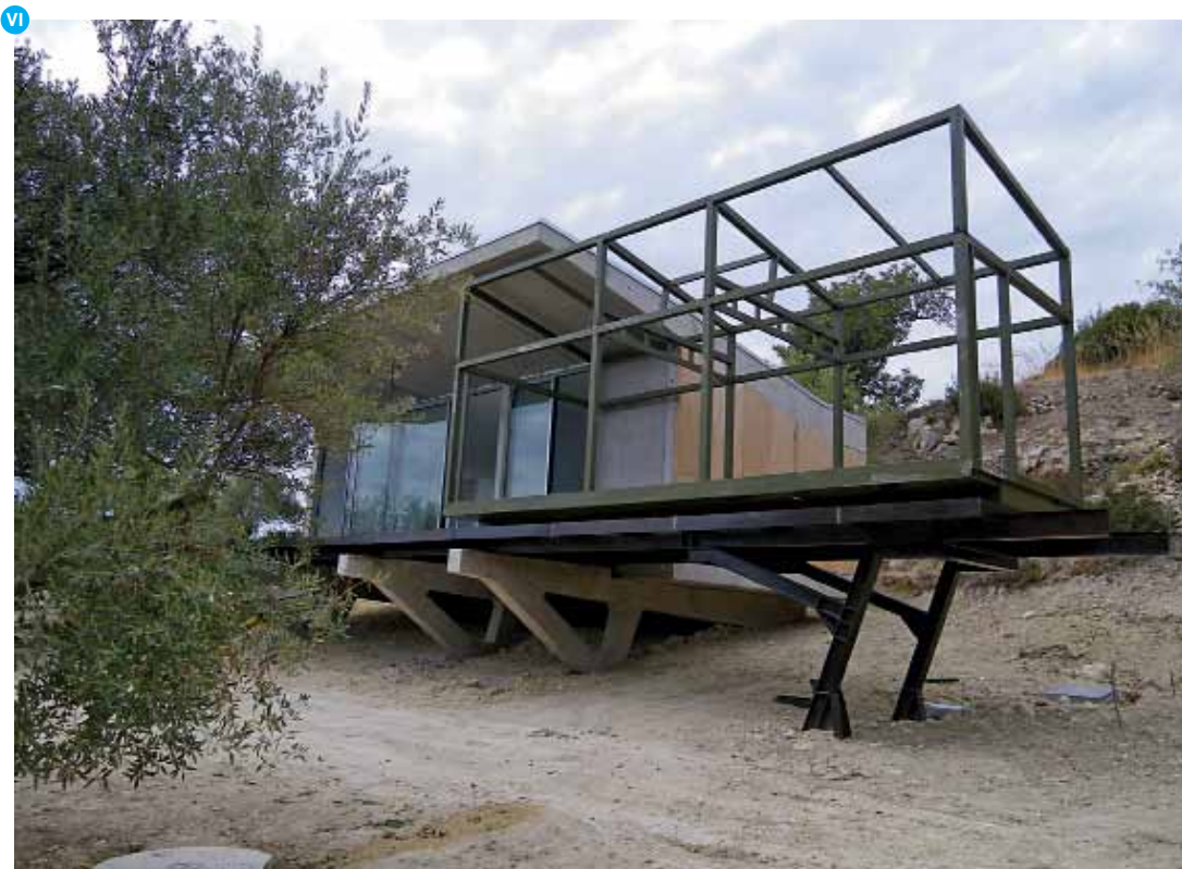
VI, VII La struttura di acciaio del corpo mobile è stata trasportata solo una volta completata. Per ridurre la dispersione si è ricorso alla coibentazione e formazione di parete ventilata in okumé sulle facce esterne di calcestruzzo armato • The steel structure of the mobile volume was only transported once completed. To reduce heat dispersion, insulation was used in conjunction with the formation of a ventilated wall in okumé over the outer reinforced concrete sides
