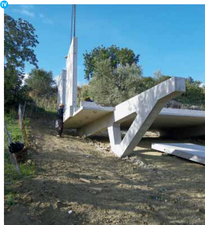
I Il terreno di natura argillosa è in forte pendenza. Questo ha obbligato a escludere le soluzioni strutturali più comunemente utilizzate • The clayey ground lies on a steep slope. This factor excluded the use of more common structural solutions.
