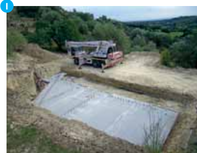
I Il terreno di natura argillosa è in forte pendenza. Questo ha obbligato a escludere le soluzioni strutturali più comunemente utilizzate • The clayey ground lies on a steep slope. This factor excluded the use of more common structural solutions.
