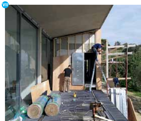
VI, VII La struttura di acciaio del corpo mobile è stata trasportata solo una volta completata. Per ridurre la dispersione si è ricorso alla coibentazione e formazione di parete ventilata in okumé sulle facce esterne di calcestruzzo armato • The steel structure of the mobile volume was only transported once completed. To reduce heat dispersion, insulation was used in conjunction with the formation of a ventilated wall in okumé over the outer reinforced concrete sides
