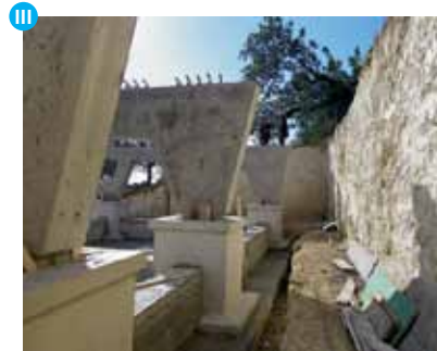
II-V La struttura del corpo fisso è di cemento armato prefabbricato. La difficoltà di accesso ha obbligato a sezionare in due le travi di sostegno • The fixed volume's structure is in prefabricated reinforced concrete. Lack of accessibility required the load-bearing beams to be split into two sections
